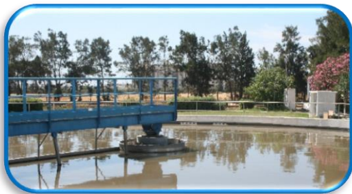
Station d'épuration des eaux usées Nabeul - ONAS
