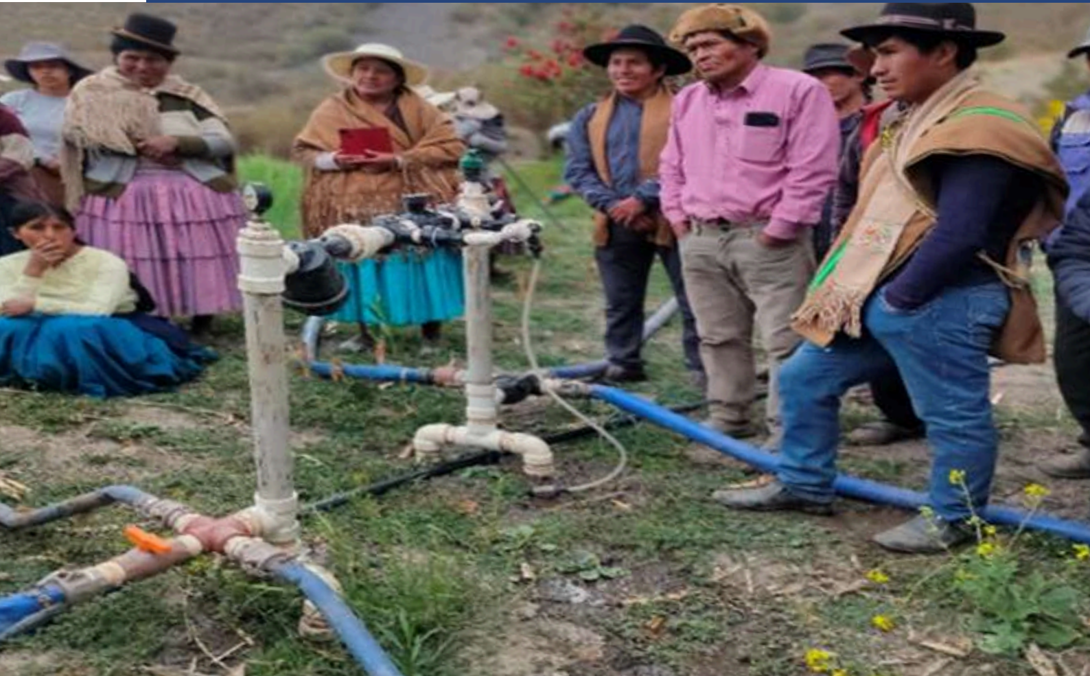
Costruzione del sistema idrico nella comunità di Jancosuni
